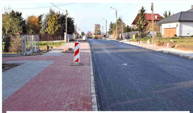
■ Przebudowaliśmy kilometrowy odcinek ul. Zaleskiej z nowym chodnikiem i ścieżką rowerową.
