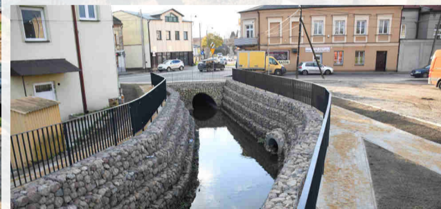
■ Koryto rzeki Strawy ozdobiliśmy kamiennymi gabionami i zabezpieczyliśmy metalową balustradą.
