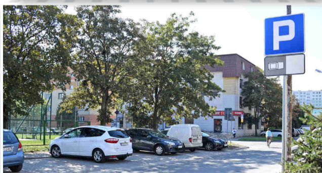
■ Zwiększyliśmy ilość miejsc parkingowych w zachodniej części miasta poprzez budowę zatok postojowych, jak np. na ul. Daniłowskiego.
