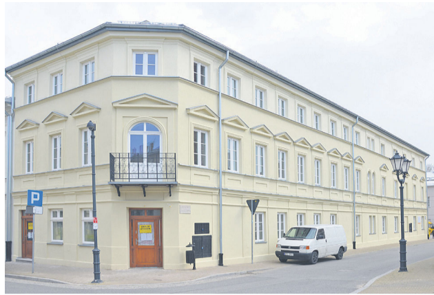
Wyremontowana kamienica przy ul. Zamurowej 16...
