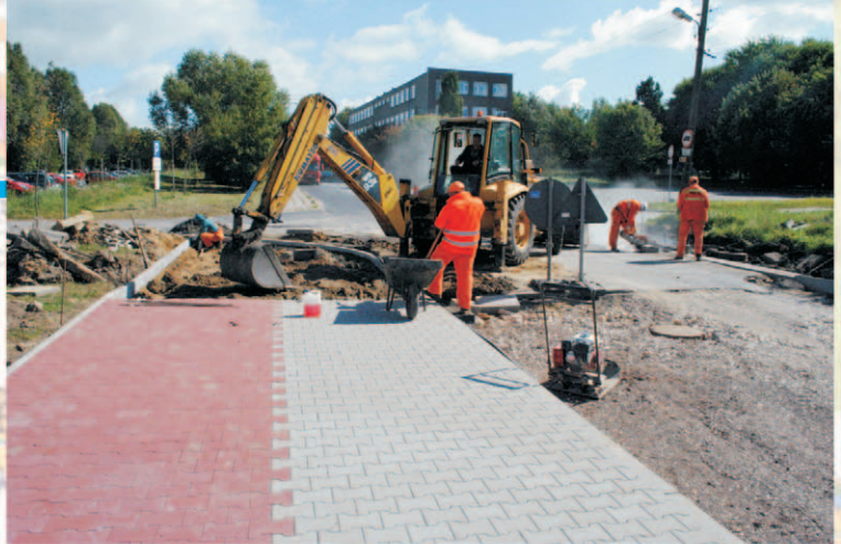
Budowa i remonty dróg oraz parkingów do 2014 roku
