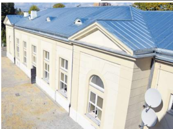
■ .....ale też kompleksowo wyremontowana na zewnątrz
