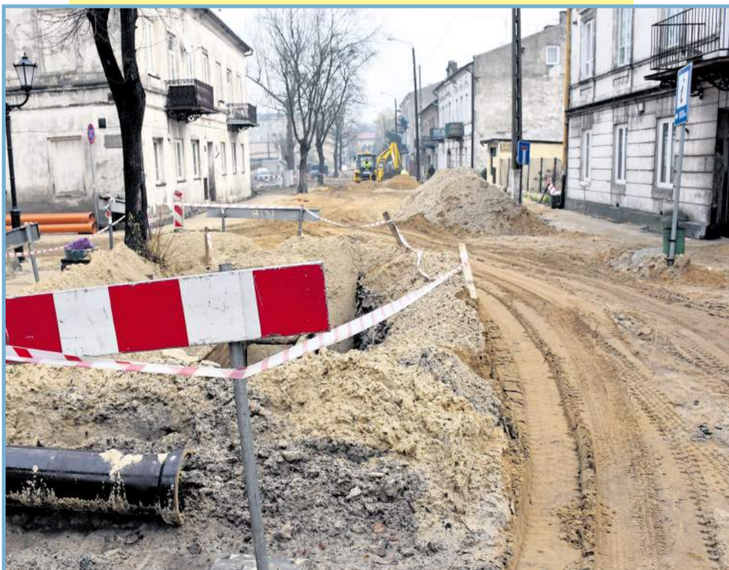
■ Na ul. Garncarskiej trwa wymiana sieci wodno-kanalizacyjnej
