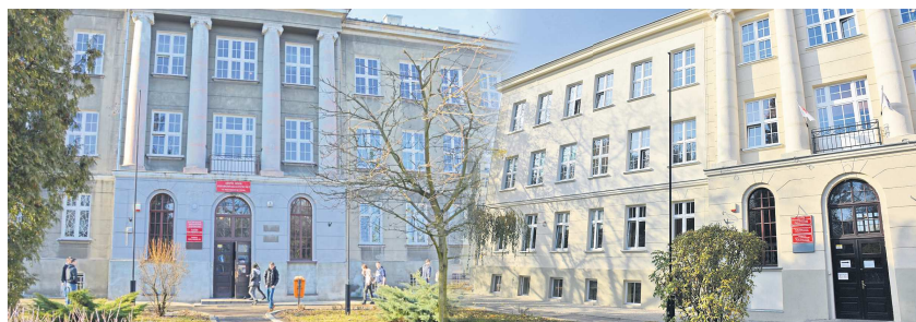
■ Tak wyglądała elewacja ZSP nr 1 przed...
