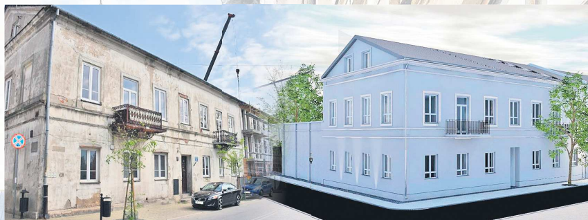
■ Tak będą prezentować się przebudowane kamienice przy skrzyżowaniu ulic Zamurowej i Garncarskiej...
