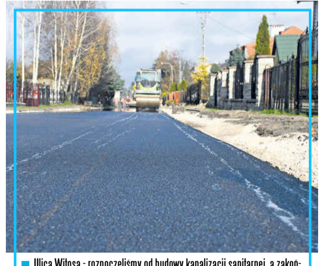
Ulica Witosa - rozpoczęliśmy od budowy kanalizacji sanitarnej, a zakończyliśmy nową nawierzchnią.
