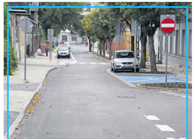
We wrześniu oddaliśmy zmodernizowaną ul. 1 Maja.
