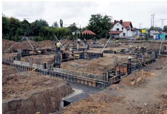
■ Budowa „Klonowej Doliny”
