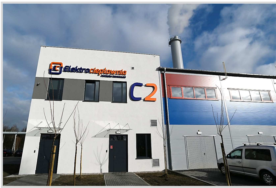
Fot. Budynek Elektrociepłowni C2
